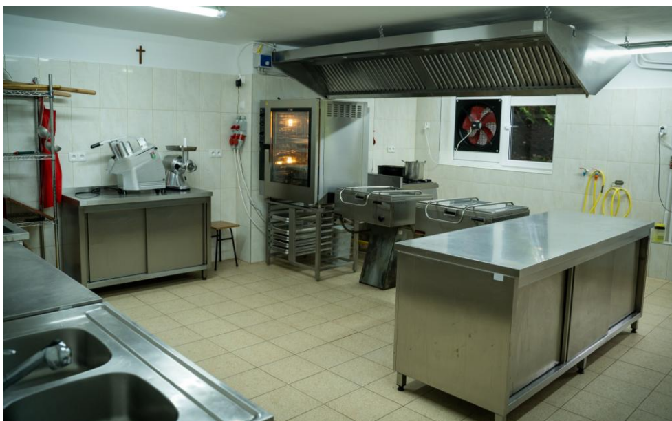
Remont w kuchni w Zespole Szkolno-Przedszkolnym w Stróżach
