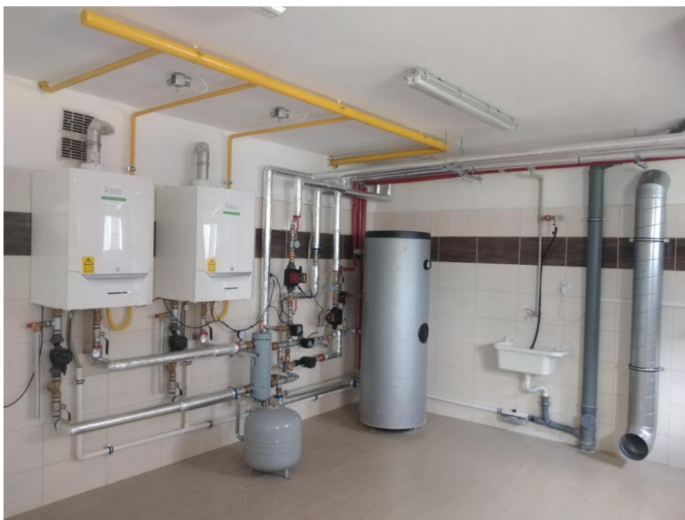
Remont kotłowni – WTZ w Siołkowej
