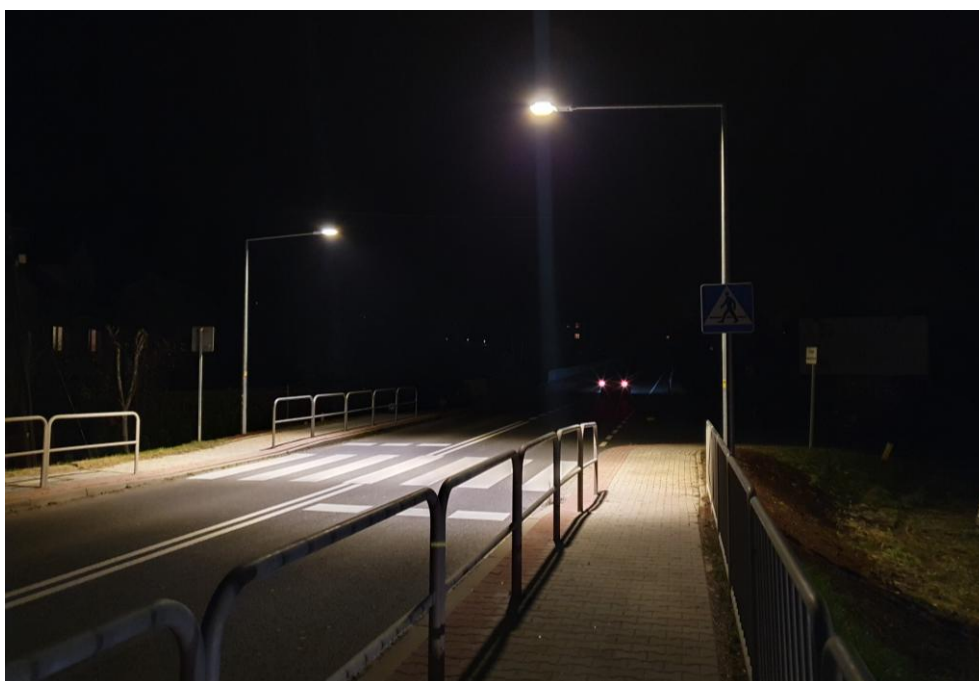
Oświetlenie przejścia dla pieszych w m. Biała Niżna
